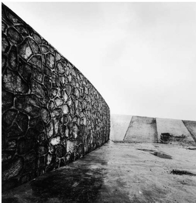
I Hubei, Sandouping, barrage des trois gorges, février 2005
